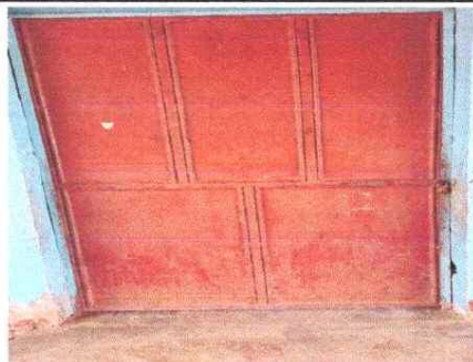
Foto 10: mantenimiento de puerta
