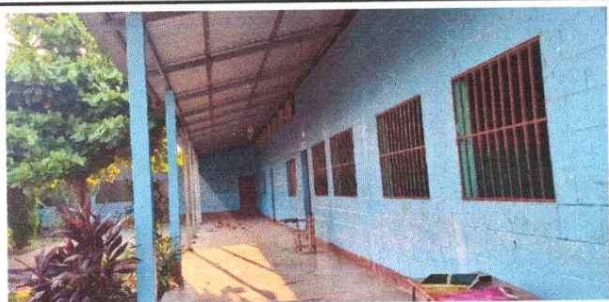
Foto 17: Pintura exterior y mantenimiento de balcones
