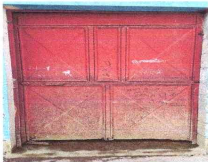
Foto 9: sustitución de puerta
