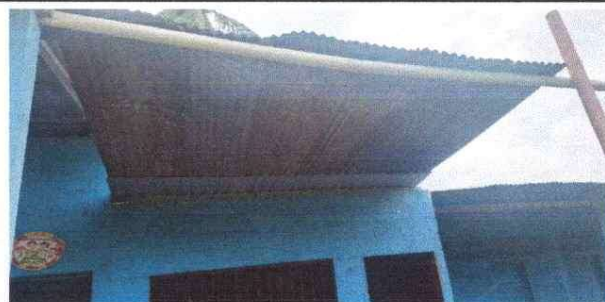
Foto 4: Sustitucion de laminas
