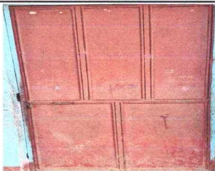
Foto 8: Mantenimiento de puerta
