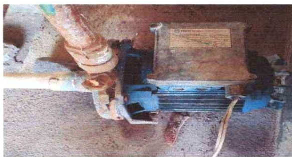
Foto 6 Sustitucion de la bomba de agua
