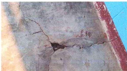
Foto 3: sustitucion de piso corredor 2
