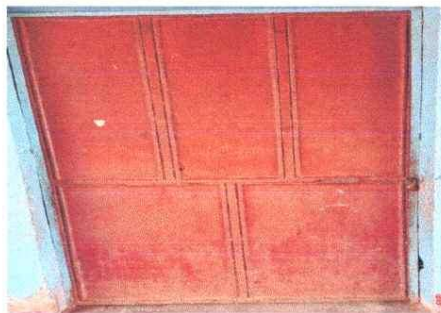
Foto 12: mantenimiento de puerta
