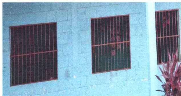
foto 5 Sustitucion de balcones
