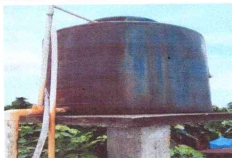
Foto 18: Sustrucción del deposito de agua 1,100 litros
