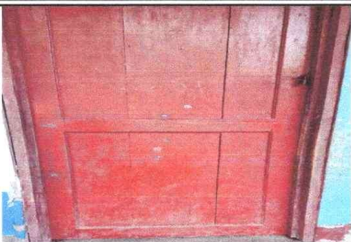
Foto1: sustitucion de puerta
