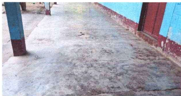
Foto 2: sustitucion de piso corredor 1
