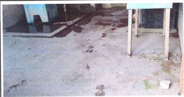
Foto 13 Sustrucción de piso de torta de concreto en la cocina
